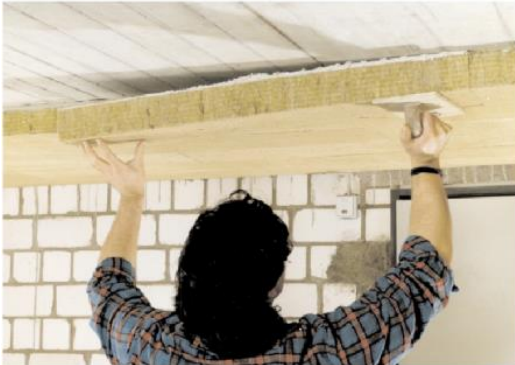
Abbildung 6: Anbringen Dämmung Kellerdecke
