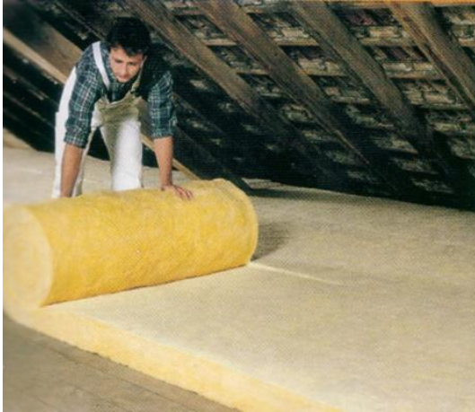
Abbildung 5: Anbringen Dämmung oberste Geschossdecke
